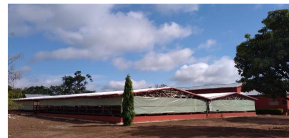
Aire de séchage Vue extérieure
