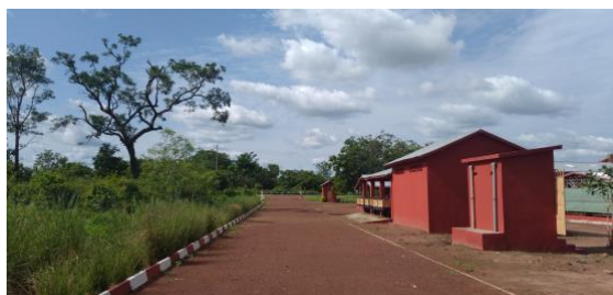
Toilettes externes pour MOD, petit magasin et piste d'accès
