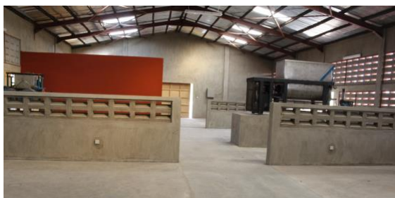
Unité de production Intérieur
