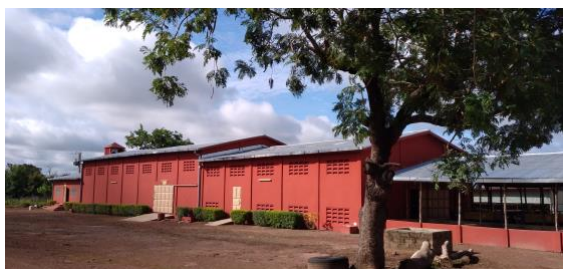
Bureaux, Entrepôt, Unité de production des amandes et aire de déchargement
