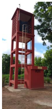
Château d'eau & Local technique pour le transformateur SBEE 150 kilowatt
