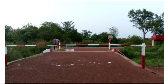
Entrée du site bord goudron RNIE06 avec barrière et guérite (non visible)
