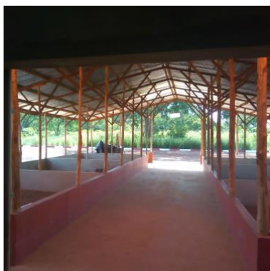
Aire de réception des matières premières
