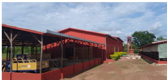
Aire de déchargement & réception des matières premières
