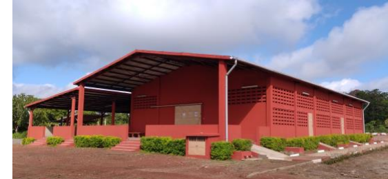
Unité de production Vue de face trois-quart
